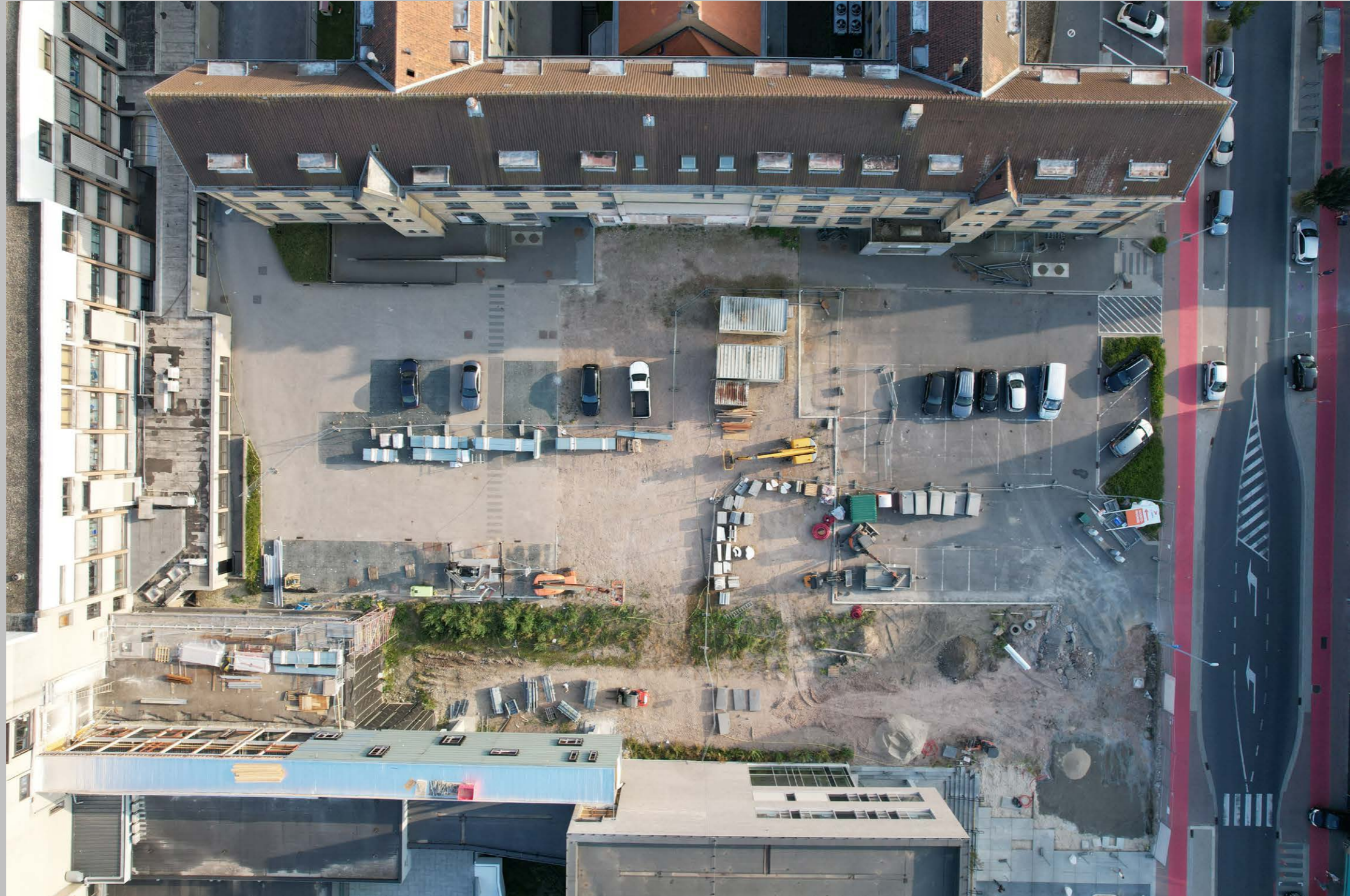
top view Gasthuissite - locatie nieuwe parking Welzijnshuis
