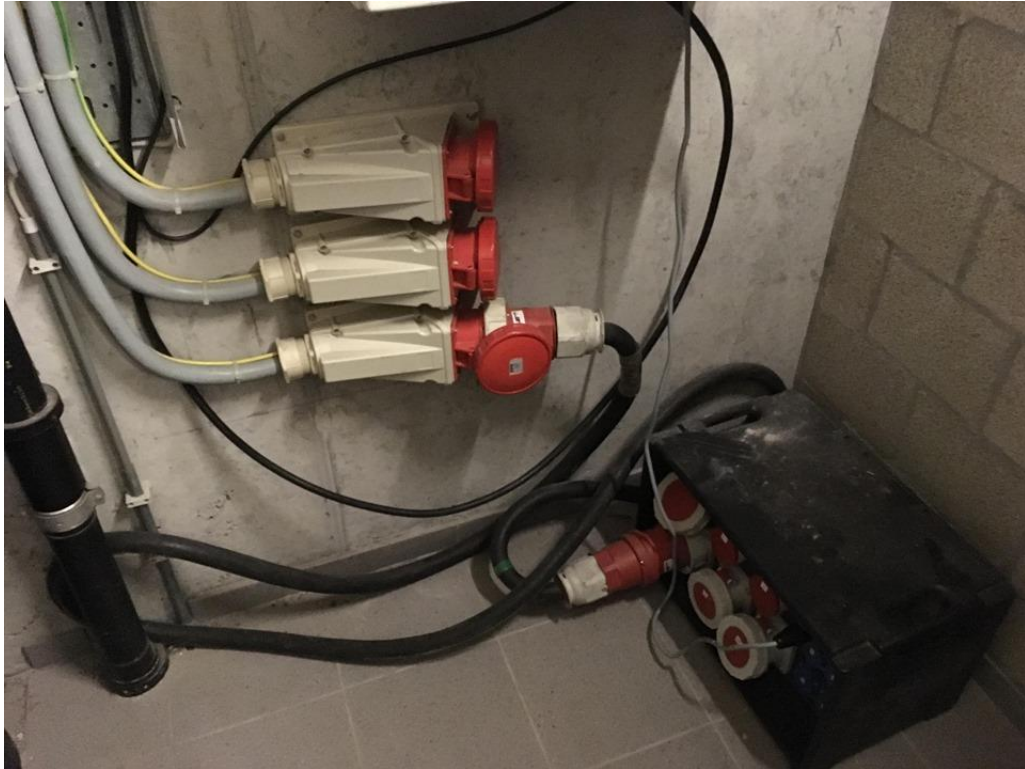
Aansluitingen 125A in berging
