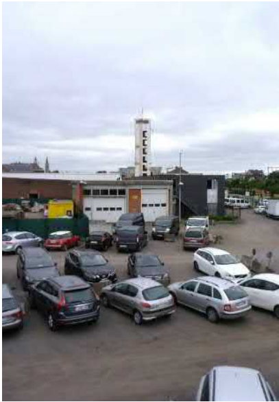
Figuur: toren van het brandweergebouw Roeselare
