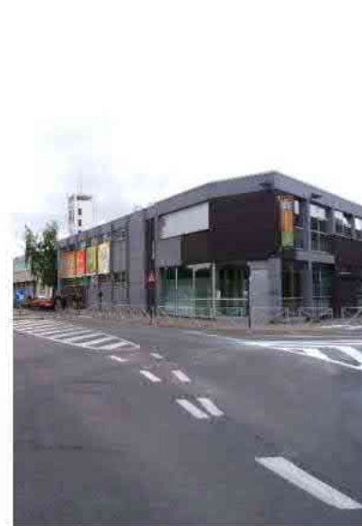
Figuur: hoekgebouw VTI Roeselare, twee bouwlagen hoog
