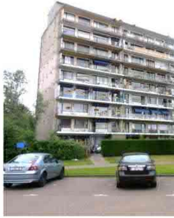
Figuur: appartementsgebouw met wachtgevel
