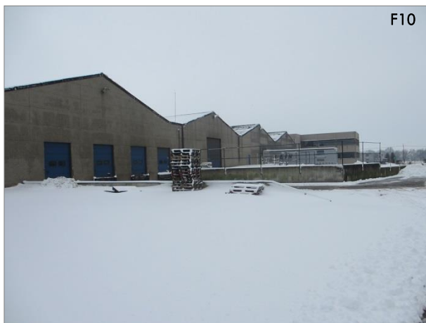
Zicht op loodsen voor opslag
