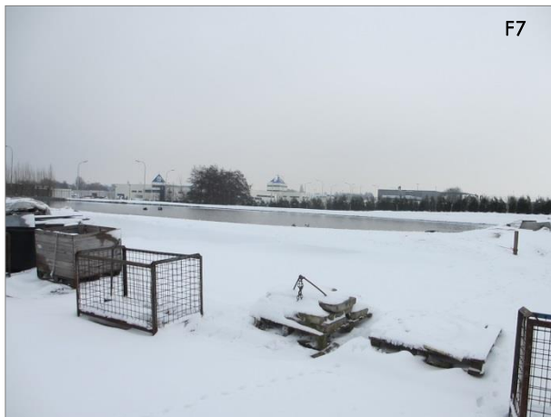
Zicht op bufferbekken
