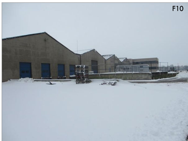
Zicht op loodsen voor opslag
