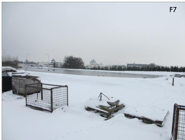
Zicht op bufferbekken
