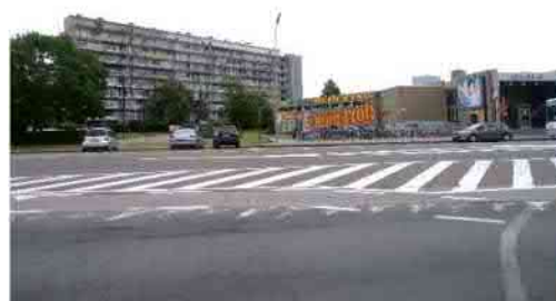
Foto 05: Het leegstaande Spillebad, aan de rechterzijde met opschrift 'mijn stad, mijn trots' en appartementsblok aan linkerzijde.
