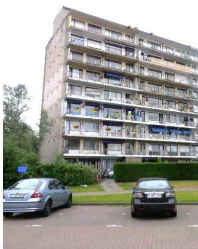
Figuur 2-22: appartementsgebouw met wachtgevel
