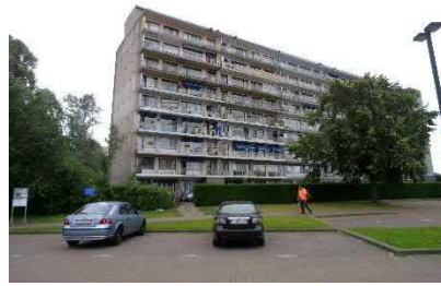
Figuur 4-19: appartementsgebouw met blinde gevel
