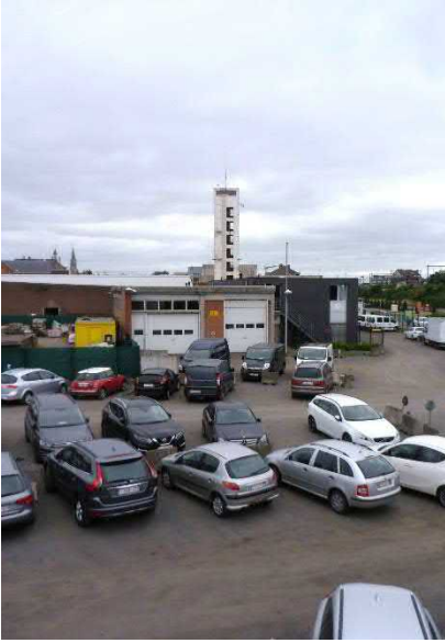
Figuur 2-28: toren van het brandweergebouw Roeselare
