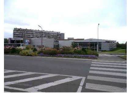
Figuur 4-20: voormalig Spillebad
